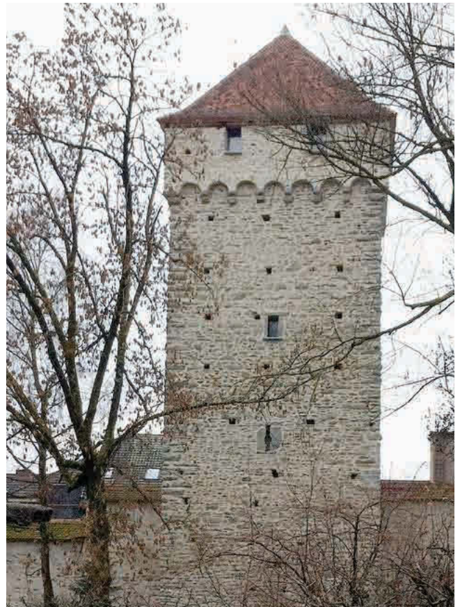
Der Pulverturm nach der sanften Sanierung (Foto Sebastian Meyer)
