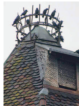
Dohlen auf der Krone des Wasserturms (Foto Bea Ess)
