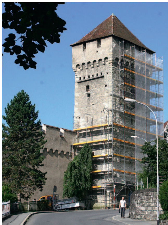
Sanierung des Allenwindenturms in Etappen (Foto Sebastian Meyer)
