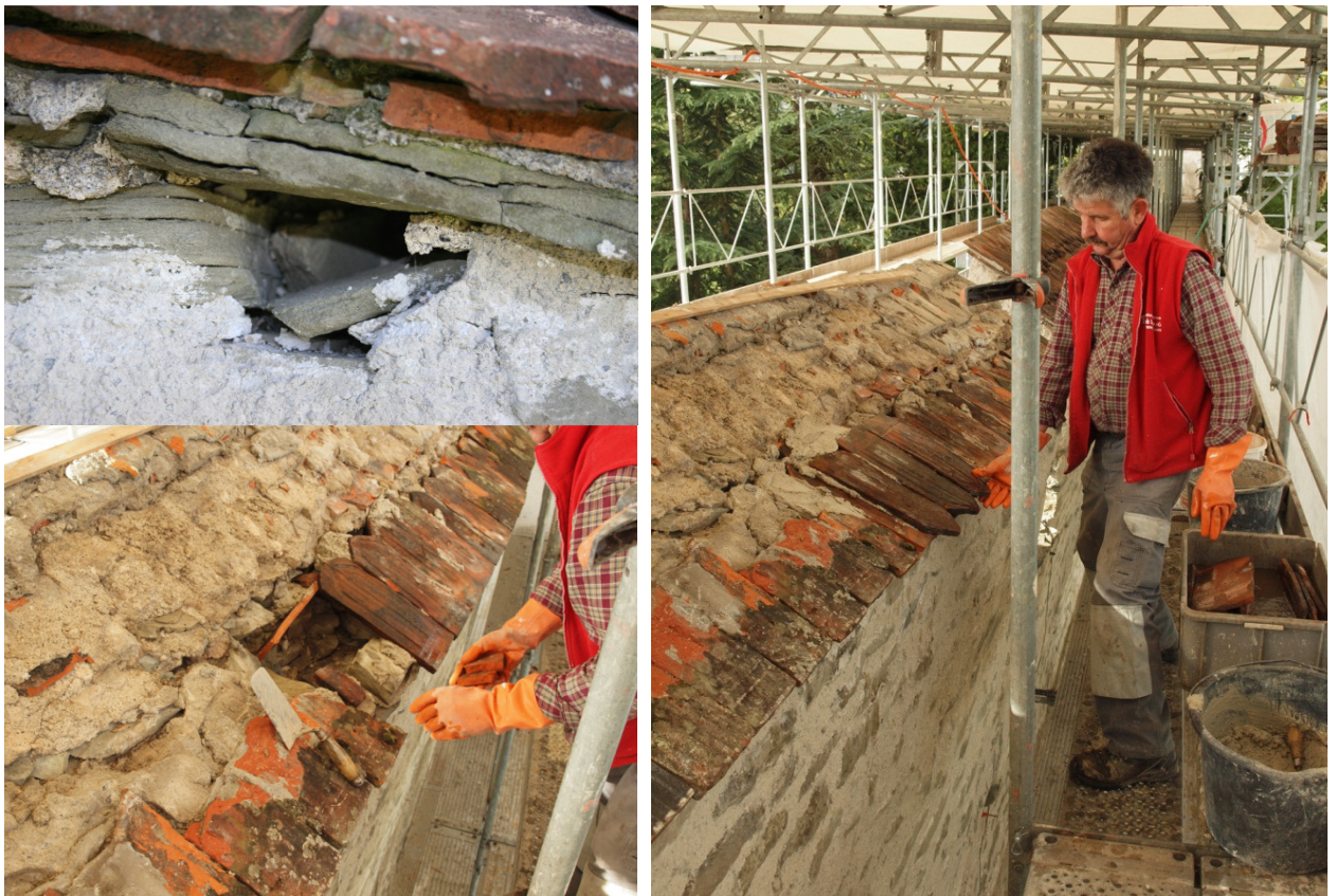
Abbildung 2: Gestaltung einer Fledermausnische unter den Ziegeln durch Walter Würsch.
