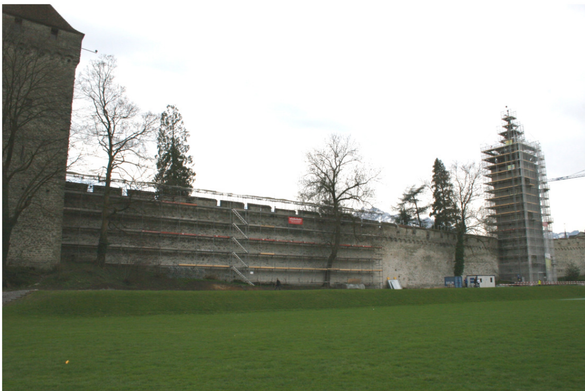
Abbildung 8: Ansicht der Mauernordseite mit dem nur im Bereich des östlichen Abschnitts erstellten Gerüsts (Foto: Sebastian Meyer)
