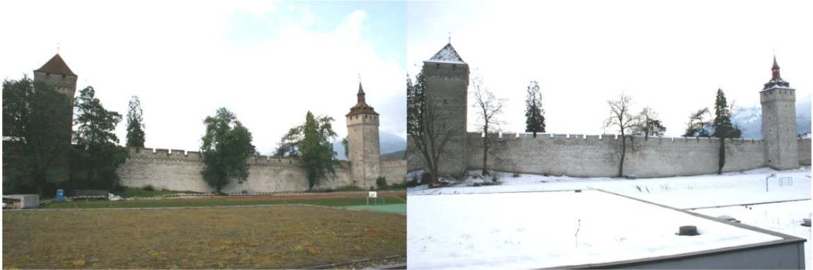
Abbildung 16: Museggmauer zwischen Zyt- und Schirmerturm vor (links) und nach (rechts) der sanften Sanierung. (Fotos: Sebastian Meyer)
