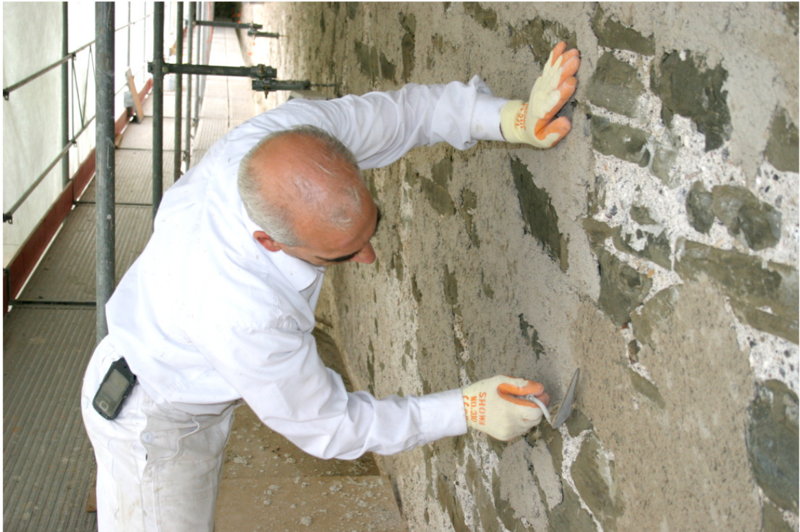
Abbildung 15: Franco Mazzai beim Aufbringen des neuen Verputzes. (Foto: Sebastian Meyer)
