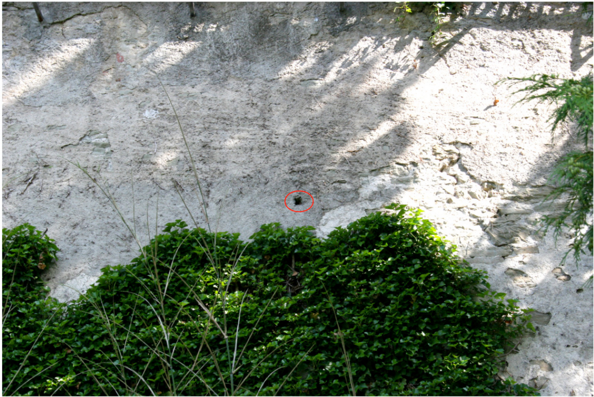
Abbildung 12: Mauersegler-Brutplatz auf der Südseite vor der sanften Sanierung (Foto: Sebastian Meyer)
