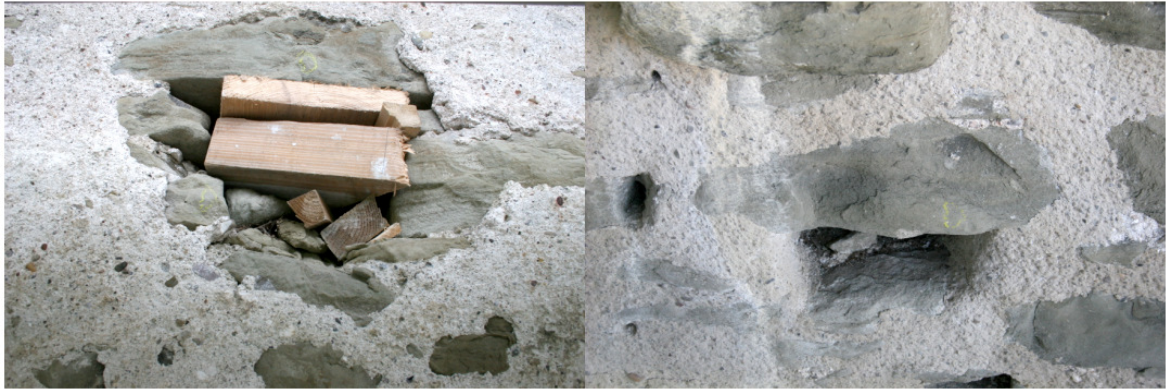
Abbildung 13: Ein Dohlen-Brutplatz (mit Holzkeilen temporär verschlossen, damit keine Dohlen vor Beginn der Arbeiten darin zu brüten beginnen) vor (links) und nach (rechts) der sanften Sanierung (Fotos: Sebastian Meyer)
