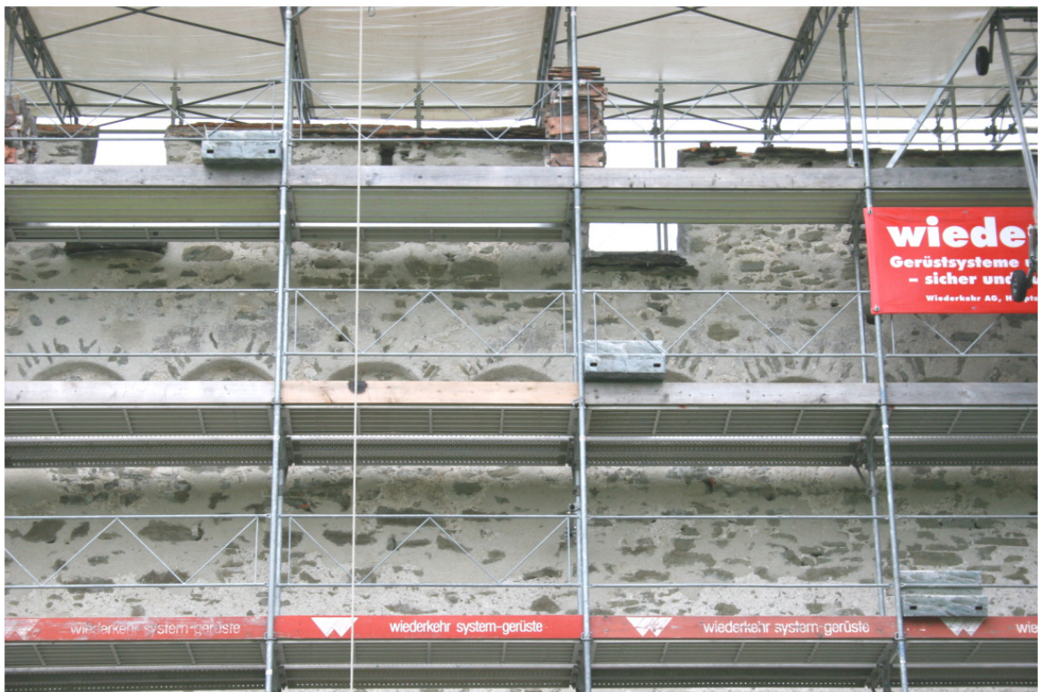
Abbildung 9: Ein Mauersegler-Nistkästen am Gerüst montiert (Foto: Sebastian Meyer)
