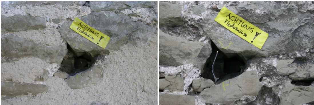
Abbildung 1: Fledermausnische vor und nach der Sanierung. Höhlen und Spalten mit Fledermauskot wurden mit solchen Klebern gekennzeichnet. (Fotos: Sebastian Meyer)
