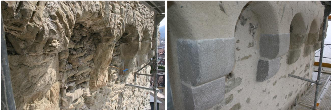
Abbildung 18: Ausschnitt aus der Fassade vor (oben) und nach (unten) der sanften Sanierung. (Fotos: Sebastian Meyer)
