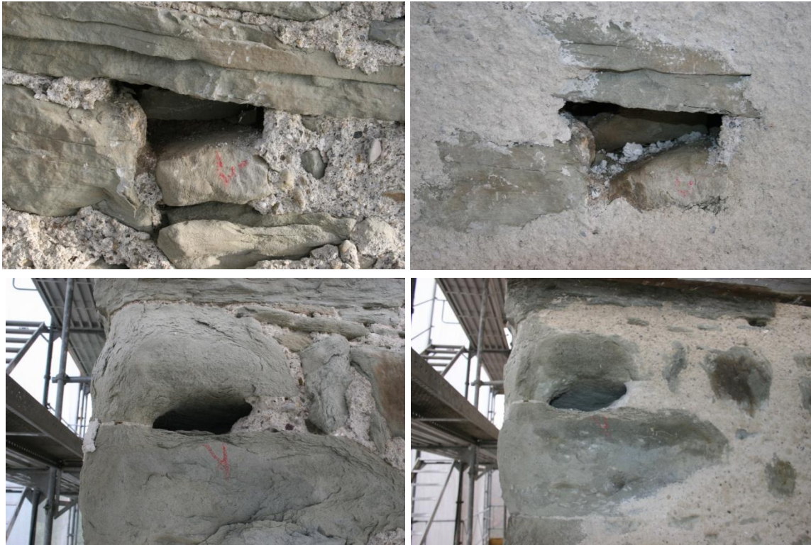
Abbildung 11: Mauersegler-Brutplätze vor (links) und nach (rechts) der sanften Sanierung. (Fotos: Sebastian Meyer)
