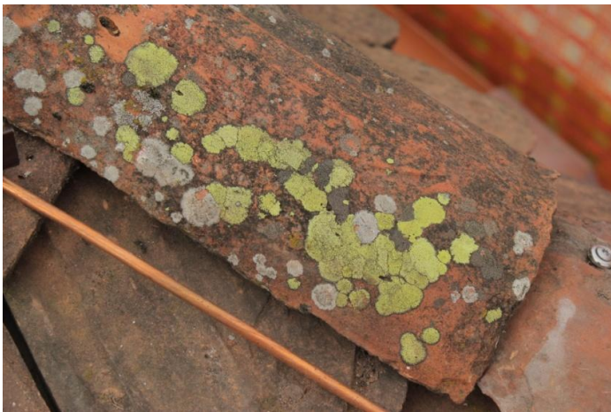
Abbildung 27: Die Lager der gelben Krustenflechten Rhizocarpon geographicum blieben auf dem Dach des Allenwindenturms unversehrt erhalten, so auch auf den Firstziegeln der restaurierten Gräte.
