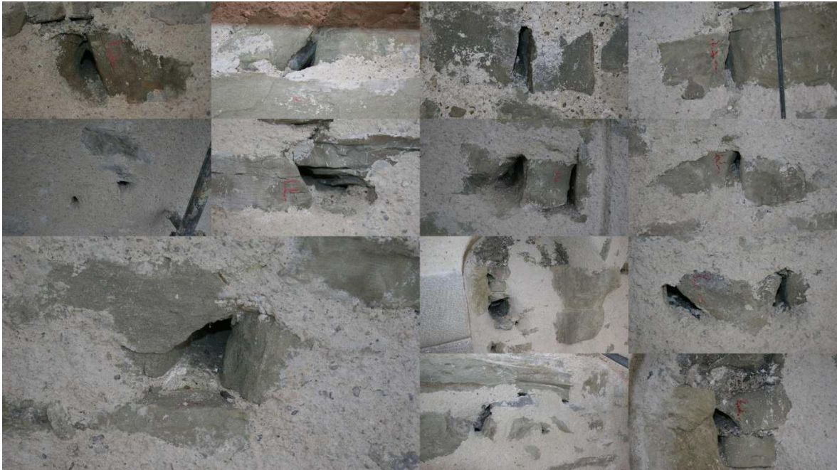
Abbildung 6: Bilder nach Abschluss der Sanierung. Zahlreiche Höhlen und Spalten wurden für Fledermäuse erhalten oder neu geschaffen.
