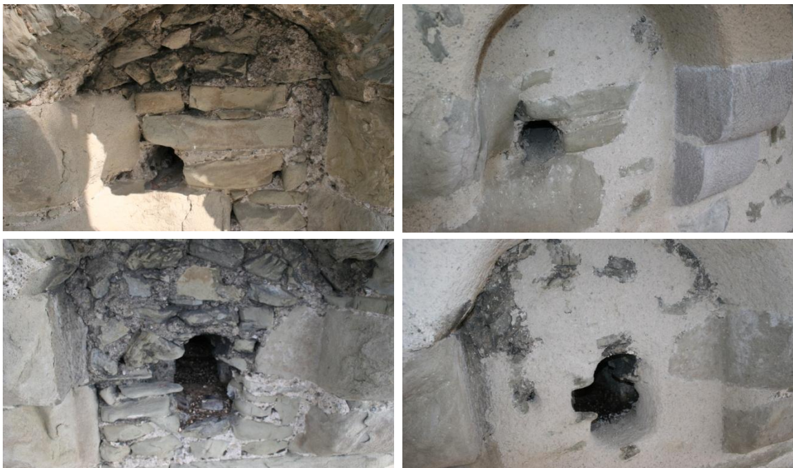
Abbildung 12: Potenzielle Dohlen-Brutplätze vor (links) und nach (rechts) der sanften Sanierung. (Fotos: Sebastian Meyer)
