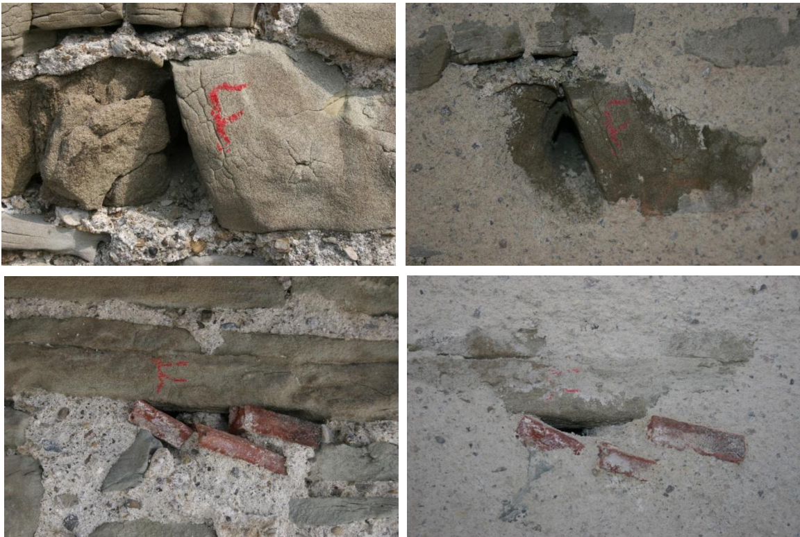
Abbildung 5: Fledermaus-Quartiere vor (links) und nach (rechts) der sanften Sanierung. (Fotos: Sebastian Meyer)
