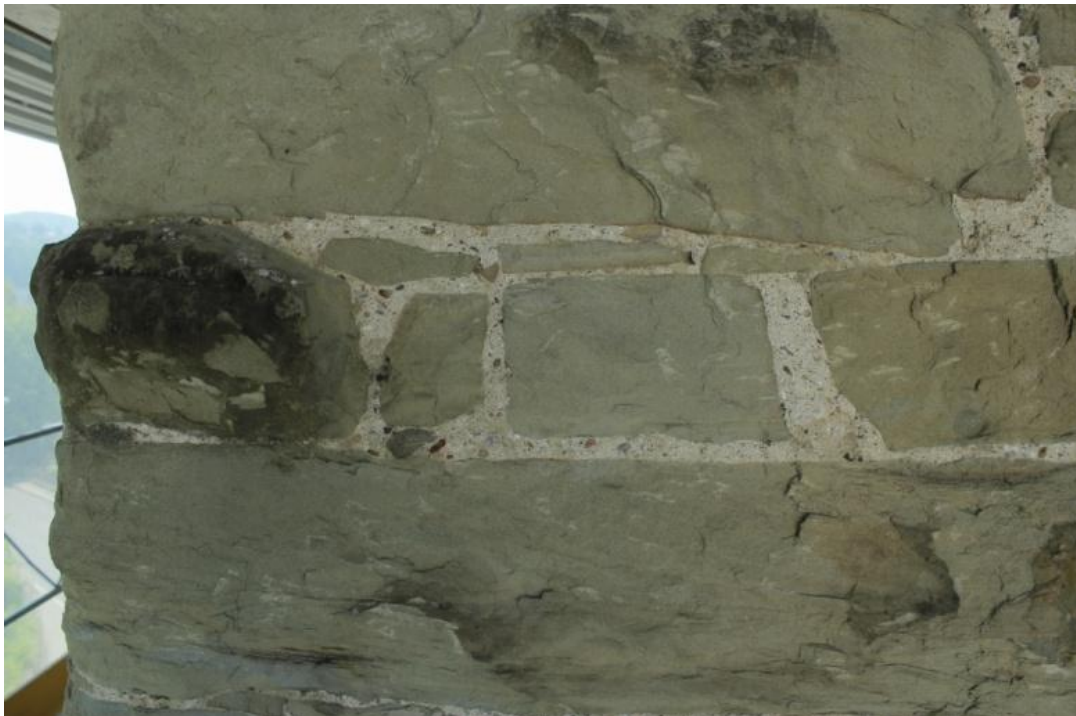
Abbildung 21: Nur vereinzelt weisen die Sandsteinflächen noch einen Flechtenbewuchs auf, insbesondere an herausragenden Blöcken an den Kanten.
