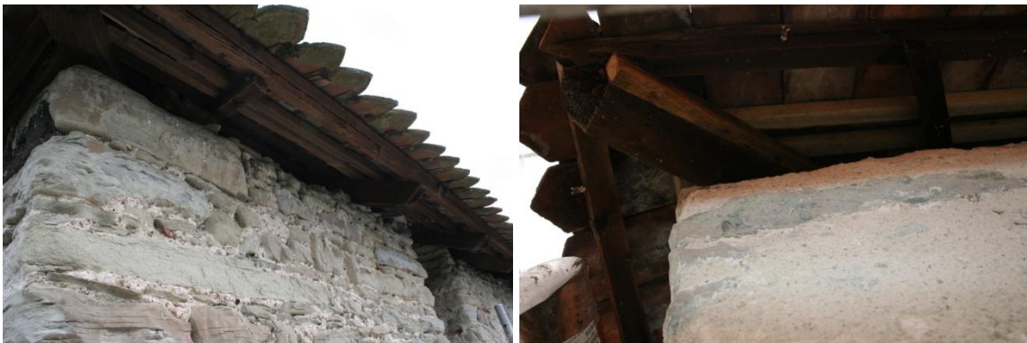
Abbildung 9: Alpensegler-Brutplatz vor (links) und ein anderer nach (rechts) der sanften Sanierung. (Fotos: Sebastian Meyer)
