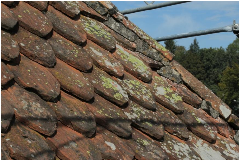
Abbildung 23: Die Gräte des Allenwindenturm-Daches weisen nur vereinzelt Stellen mit Mörtelflicken auf. Ansonsten ist das Ziegeldach weitgehend in gutem Zustand und trägt eine reiche, mehrheitlich aus Krustenflechten zusammengesetzte Flechtenflora.
