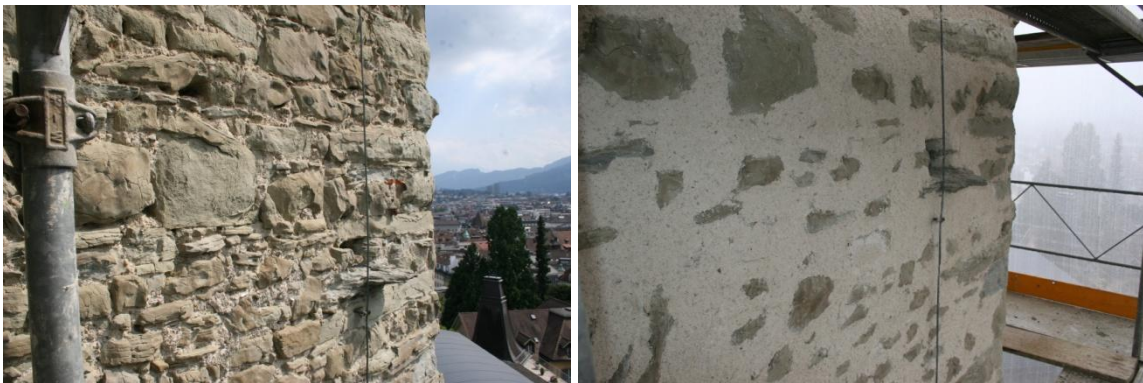
Abbildung 19: Ausschnitt aus der Fassade vor (oben) und nach (unten) der sanften Sanierung. (Fotos: Sebastian Meyer)
