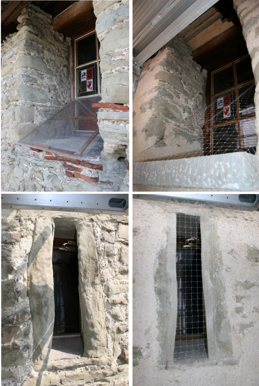
Abbildung 17: Alte (links) und neue (rechts) Taubenabwehr. (Fotos: Sebastian Meyer)
