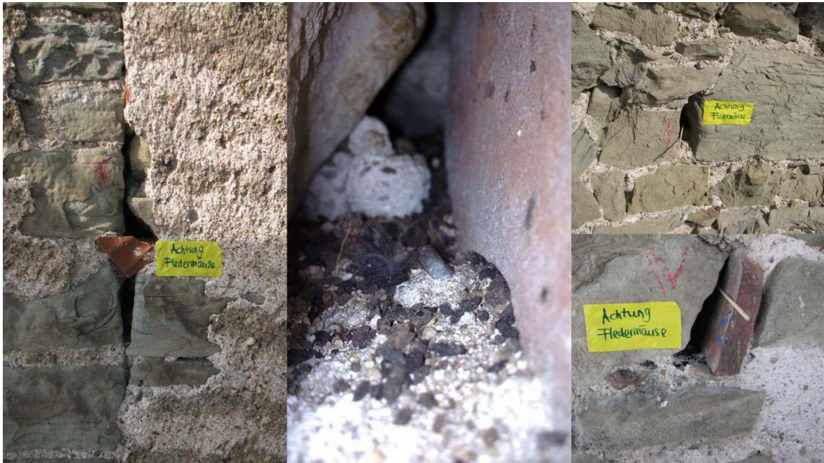
Abbildung 2: In vielen Löchern und Spalten waren Fledermausspuren (Bildmitte: Kot) zu finden. Wo Kot vorhanden war, wurden die Löcher speziell gekennzeichnet, um zu verhindern, dass bei der Sanierung Fledermäuse eingeschlossen werden (Collage vor der Sanierung).
