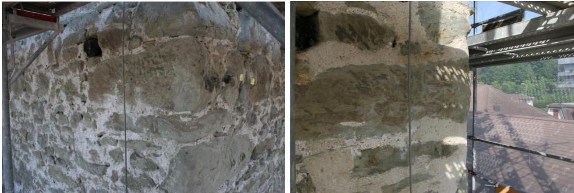
Abbildung 10: Ausschnitte der Nordost-Fassadenecke vor (links) und nach (rechts) der sanften Sanierung. (Fotos: Sebastian Meyer)
