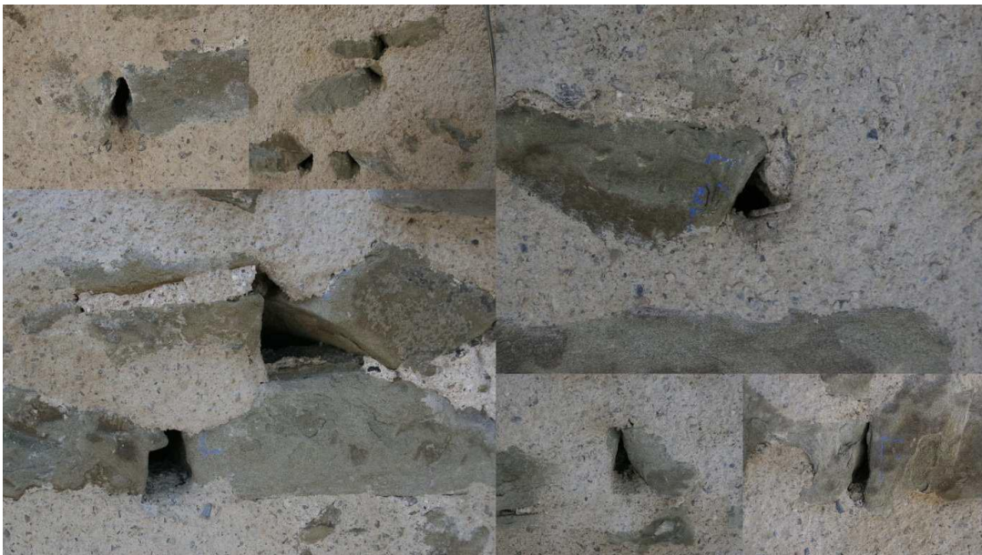
Abbildung 5: Nach Abschluss der Arbeiten sind wieder zahlreiche Löcher für Fledermäuse vorhanden (Collage nach der Sanierung).
