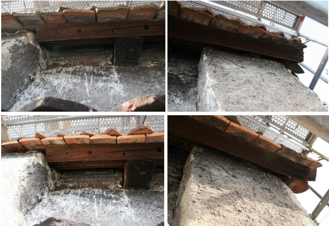
Abbildung 12: Alpensegler-Brutplatz vor (oben) und nach (unten) der sanften Sanierung. (Fotos: Sebastian Meyer)
