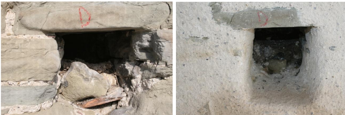
Abbildung 15: Potenzieller Dohlen-Brutplatz vor (links) und nach (rechts) der sanften Sanierung. (Fotos: Sebastian Meyer)
