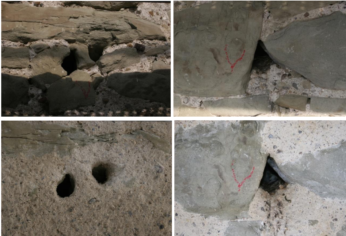
Abbildung 14: Mauersegler-Brutplatz vor (oben) und nach (unten) der sanften Sanierung. (Fotos: Sebastian Meyer)
