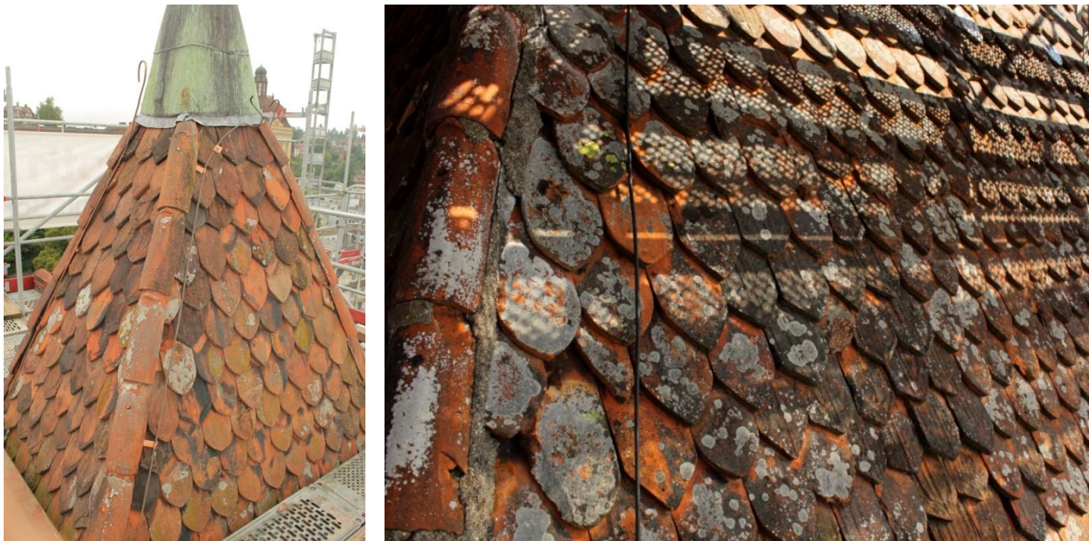
Abbildung 26: Die Turmspitze nach den erforderlichen Restaurierungsarbeiten (links). An einigen Stellen führte das Umdecken zu erkennbaren, geringfügigen Verschiebungen der Ziegel und damit der Flechtenlager (rechts).
