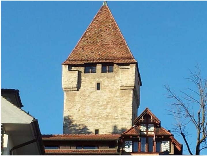
Abbildung 6: Dächliturm nach der Sanierung
