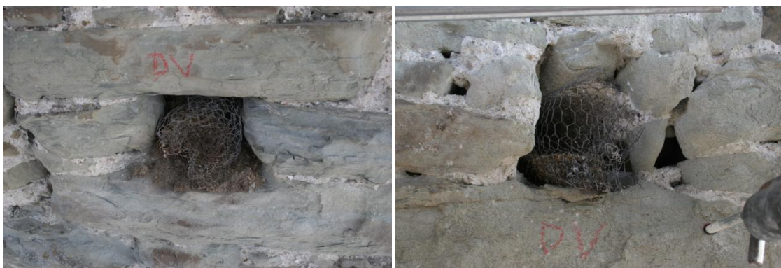
Abbildung 9: In den mit Gittern verschlossenen Löchern konnten dennoch Vogelnester gefunden werden. (Fotos: Sebastian Meyer)
