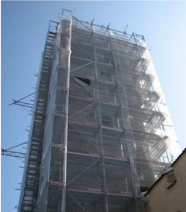
Abbildung 4: Grosse Öffnungen im Gerüstnetz ermöglichen das Ausfliegen der Fledermäuse.
