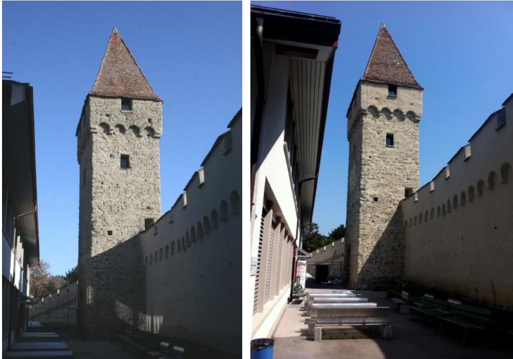
Abbildung 18: Dächliturm vor (links) und nach (rechts) der sanften Sanierung. (Fotos: Sebastian Meyer)
