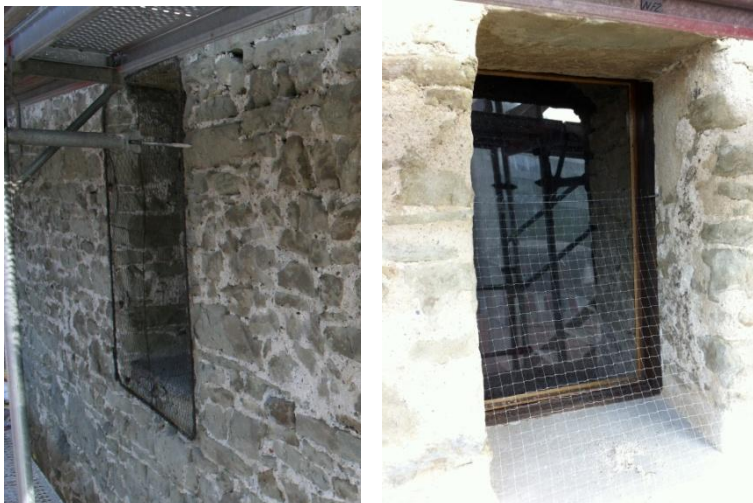
Abbildung 17: Abwehrmassnahmen gegen Strassentauben vor (links) und nach (rechts) der sanften Sanierung. (Fotos: Sebastian Meyer)
