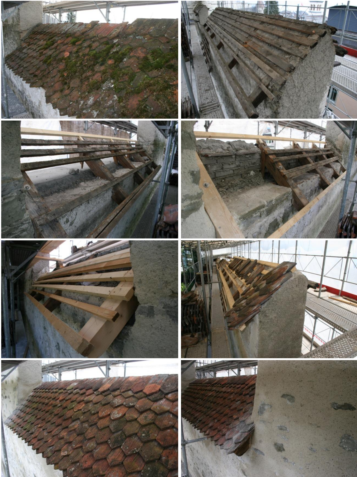
Abbildung 10: Neue Mauersegler-Brutplätze entstanden unter den Zinnenabdeckungen. Fotos von Zinnen vor, während und nach der sanften Sanierung. (Fotos: Sebastian Meyer)
