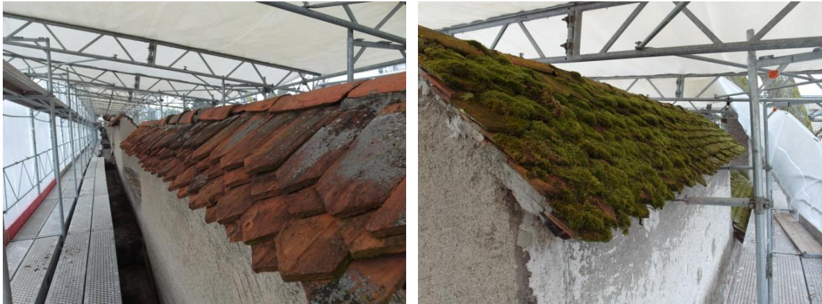
Abbildung 16: Die südexponierten Ziegel tragen eine typische, von Krusten dominierte Flechtvegetation. Die nordexponierten Zinnenflächen sind zum Teil üppig von Moos bedeckt.
