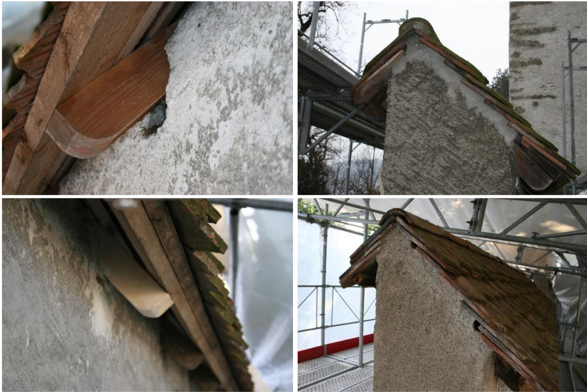
Abbildung 11: Details zu neuen Mauersegler-Brutplätzen unter den Zinnenabdeckungen. Fotos von Zinnen vor (oben) und nach (unten) der sanften Sanierung. (Fotos: Sebastian Meyer)
