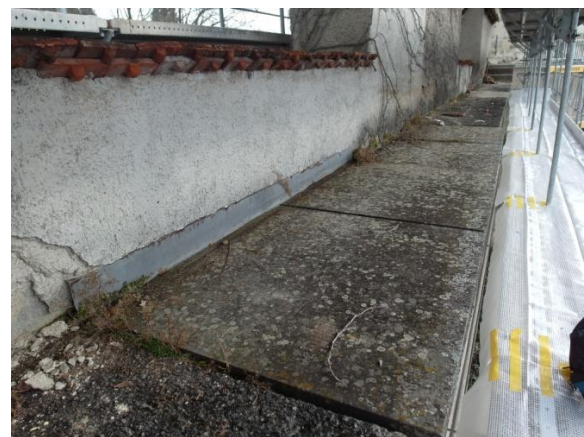
Abbildung 21: Die Abdeckung des Wehrgangs ist schadhaft und wasserdurchlässig. Richtung Allenwindenturm sind die vorhandenen Sandsteinplatten üppig mit Krustenflechten bewachsen.
