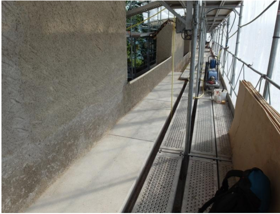
Abbildung 18: Der Putz an den Wänden des Wehrgangs ist nach den Restaurierungsarbeiten praktisch flechtenfrei, da die basalen Teile erneuert werden mussten.
