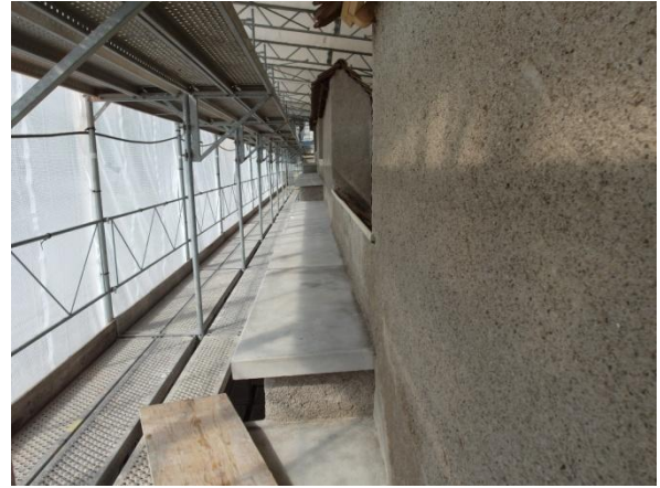
Abbildung 18: Der Putz an den Wänden des Wehrgangs ist nach den Restaurierungsarbeiten praktisch flechtenfrei, da die basalen Teile erneuert werden mussten.
