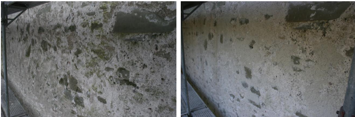
Abbildung 3: Mauerabschnitt Schirmer- bis Pulverturm vor (links) und nach (rechts) der sanften Sanierung. (Fotos: Sebastian Meyer)
