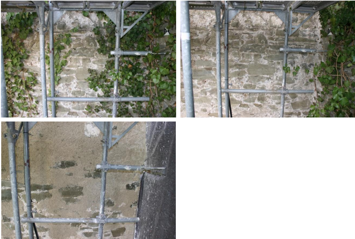
Abbildung 4: Mauerabschnitt Pulver- bis Allenwindenturm vor dem Entfernen des Efeu (links oben), vor der sanften Sanierung (rechts oben) und nach der sanften Sanierung (links unten). (Fotos: Sebastian Meyer)
