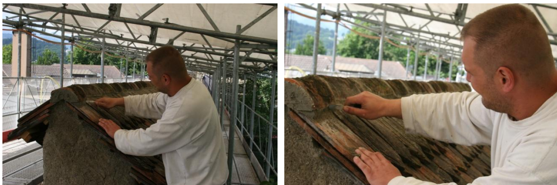
Abbildung 12: Thomas Krüger bei der Feinarbeit rund um die Zinnenabdeckungen. (Fotos Sebastian Meyer)
