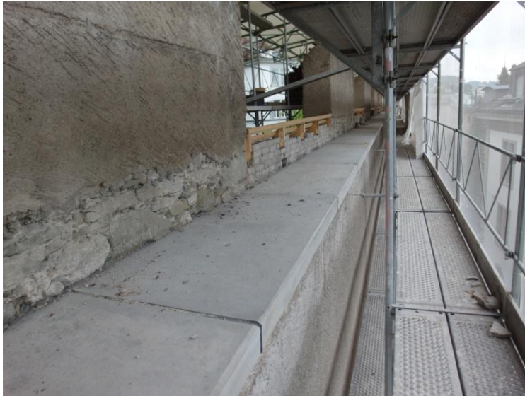
Abbildung 24: Der Putz an der Mauerbasis des Wehrgangs musste vollständig entfernt werden. Die neuen Betonplatten des Weges bleiben wohl noch lange ohne Flechtenbewuchs.
