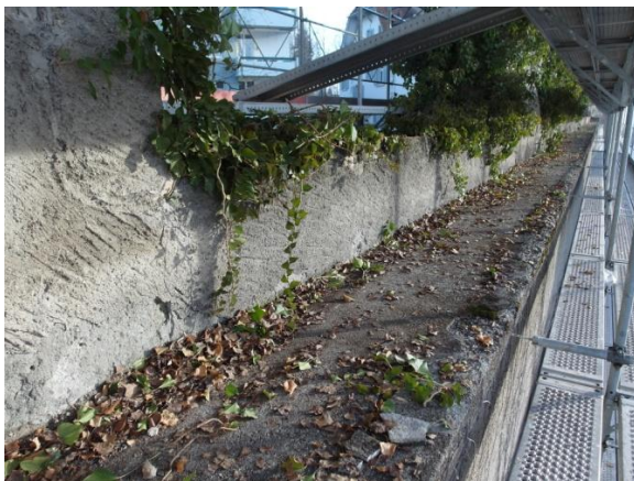
Abbildung 21: Die Abdeckung des Wehrgangs ist schadhaft und wasserdurchlässig. Richtung Allenwindenturm sind die vorhandenen Sandsteinplatten üppig mit Krustenflechten bewachsen.
