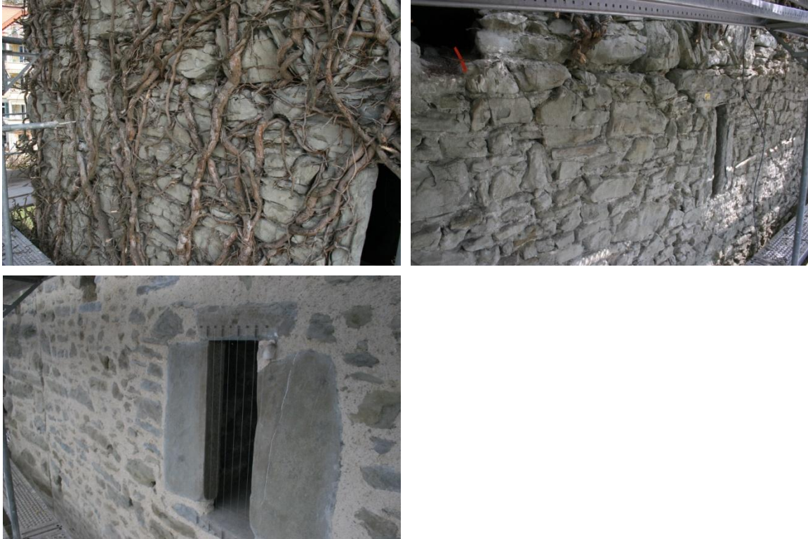
Abbildung 10: Fassadenausschnitt des Pulverturms vor (oben links) und nach (oben rechts) Entfernen des Efeus und vor der Sanierung (oben) und nach (unten) der sanften Sanierung. (Fotos: Sebastian Meyer)
