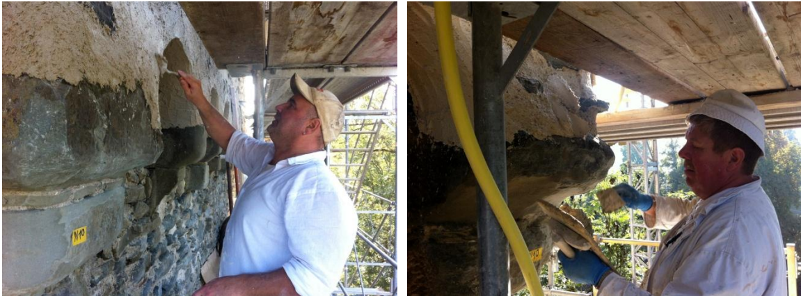
Abbildung 16: Handwerker Franco Mazzai (links) und Berndt Fickenscher (rechts) setzen die Mörtelkelle mit Vorsicht und Zielgenauigkeit ein. (Fotos: Sebastian Meyer)
