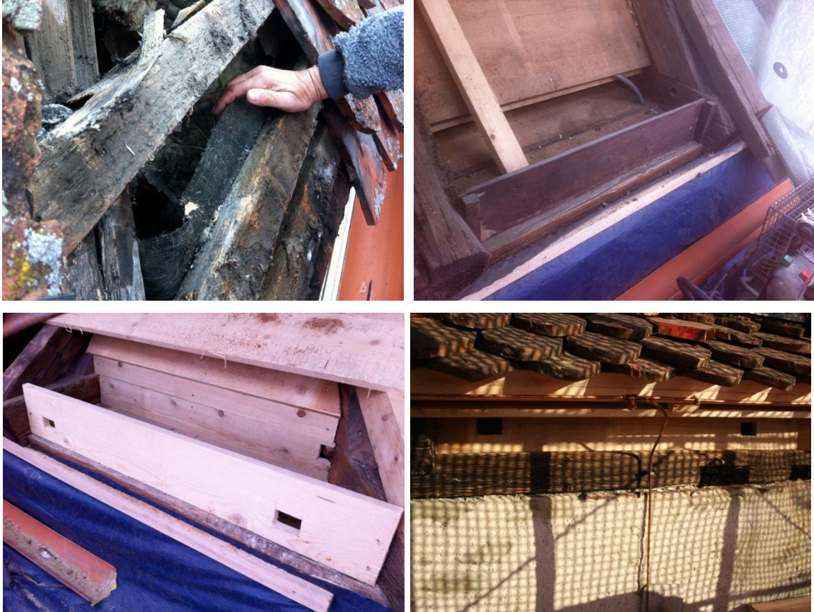
Abbildung 14: Neue Alpensegler-Brutplätze unter dem Dach vor (oben links), während (oben rechts, unten links) und nach (unten rechts) der sanften Sanierung. (Fotos: Sebastian Meyer)
