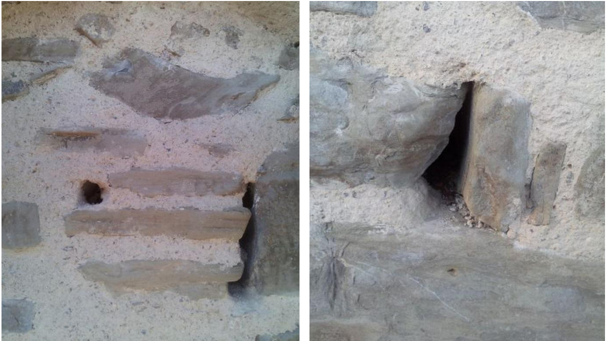
Abbildung 3: Fledermäuse nutzen Einschupflöcher verschiedenster Formen. Dem wurde bei den Sanierungsarbeiten beim Pulverturm vorbildlich Rechnung getragen.
