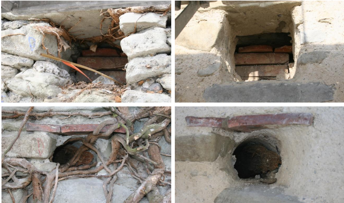
Abbildung 12: Gänsesäger-/Dohlen-Brutplätze am Pulverturm vor (links) und nach (rechts) der sanften Sanierung. (Fotos: Sebastian Meyer)
