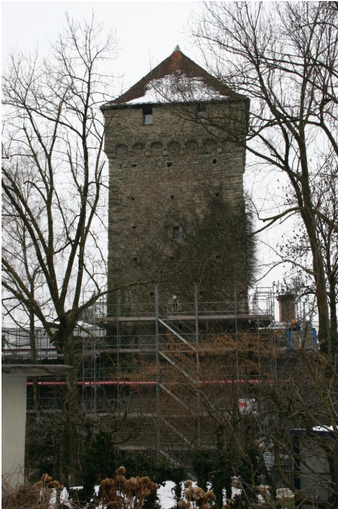
Abbildung 11: Pulverturm mit in zwei Etappen erstelltem Gerüst. (Fotos: Sebastian Meyer)
