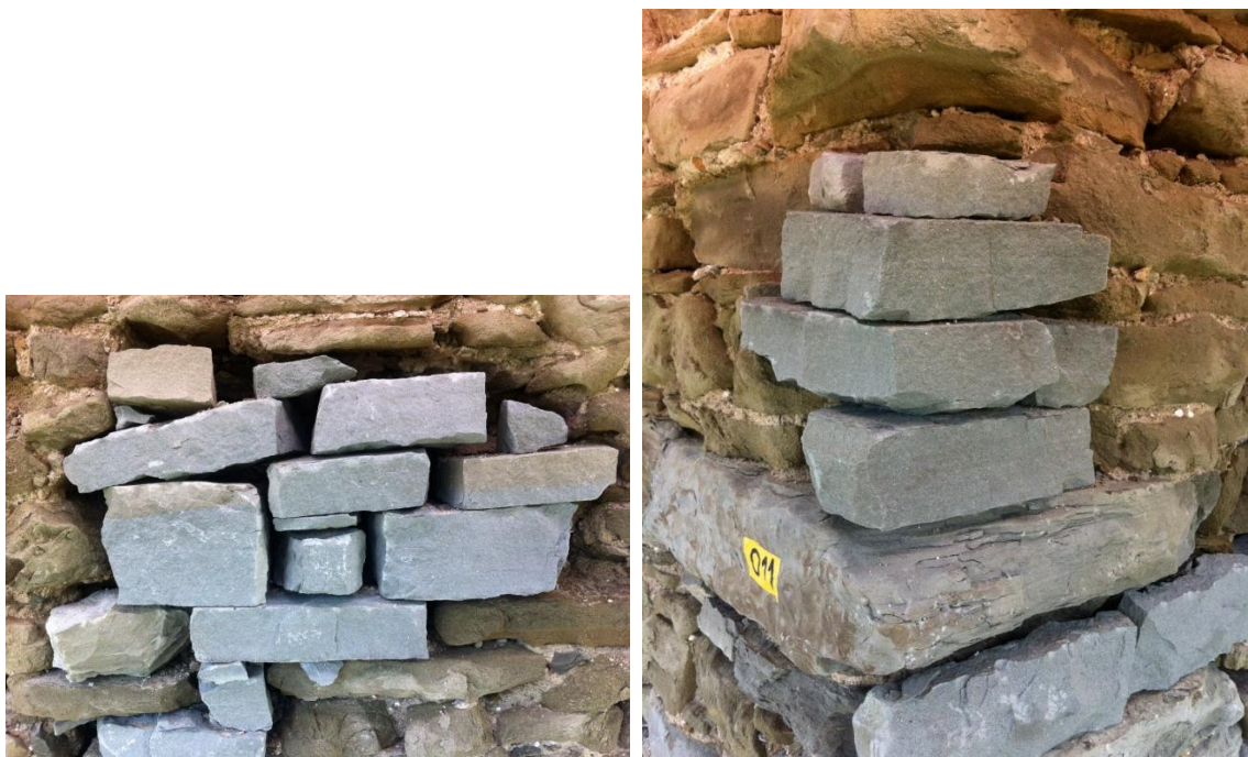
Abbildung 13: Stelle mit neu eingesetzten Steinen und Nischen für Fledermäuse und Mauersegler. (Fotos: Sebastian Meyer)
