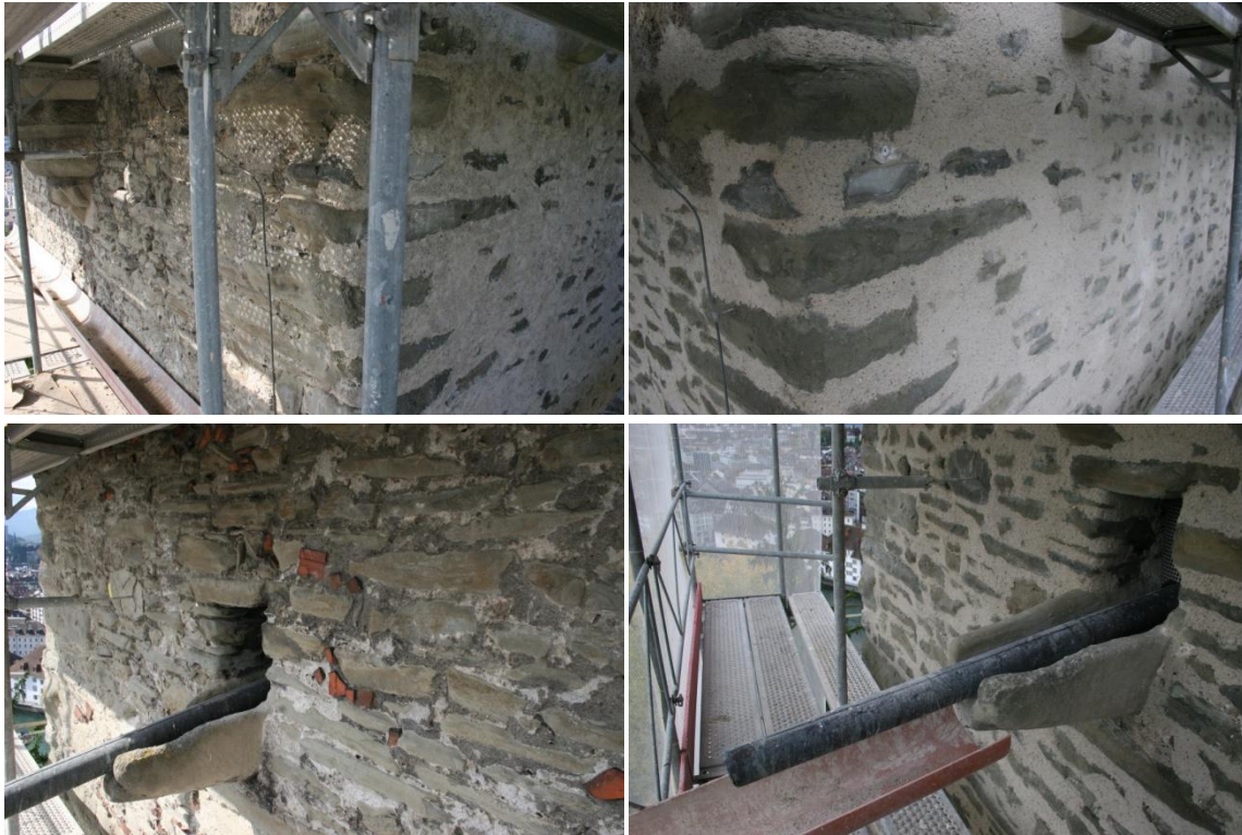
Abbildung 6: Ausschnitte vor (links) und nach (rechts) der sanften Sanierung. (Fotos: Sebastian Meyer)
