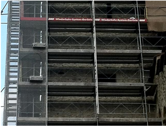
Abbildung 11: Gerüst mit Mauersegler-Ersatzkästen auf der Westseite. (Foto: Sebastian Meyer)
