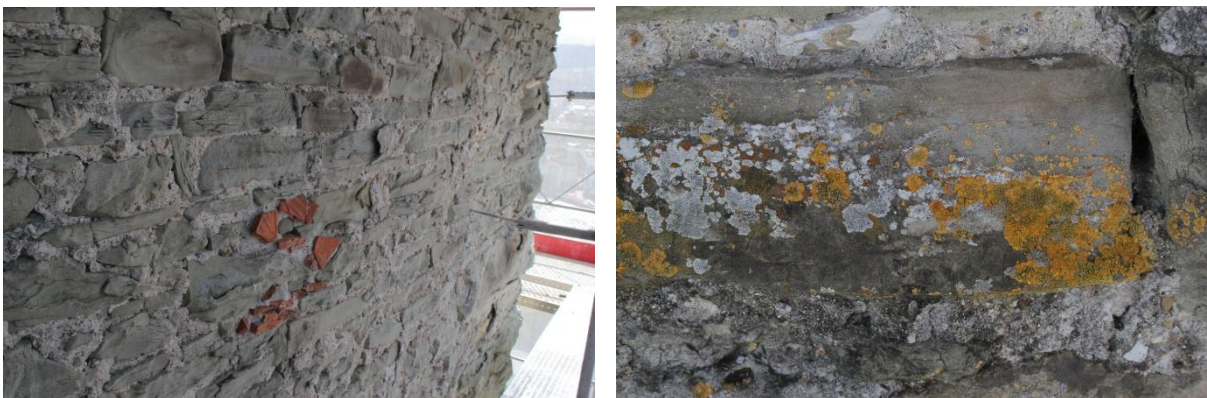
Abbildung 15: Obwohl die Mauerflächen des Männliturms vielerorts tief erodiert sind, finden sich regelmässig intakte Sandsteinblöcke mit einem dekorativen Bewuchs von Krustenflechten.
