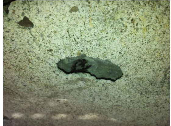
Abbildung 2: Bemerkenswert waren die Kotansammlungen hinter dem aufgesprengten Putz der Südseite.
