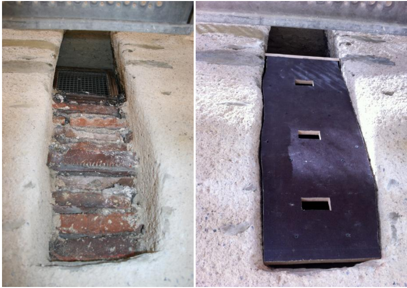
Abbildung 12: Fenster niche auf der Südseite vor (links) und nach (rechts) dem Einbau eines Mauersegler-Fledermaus-Kombikastens. (Fotos: Sebastian Meyer)
