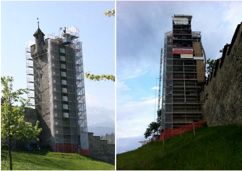
Abbildung 13: Männlerturm während der sanften Sanierung. (Fotos: Sebastian Meyer)
