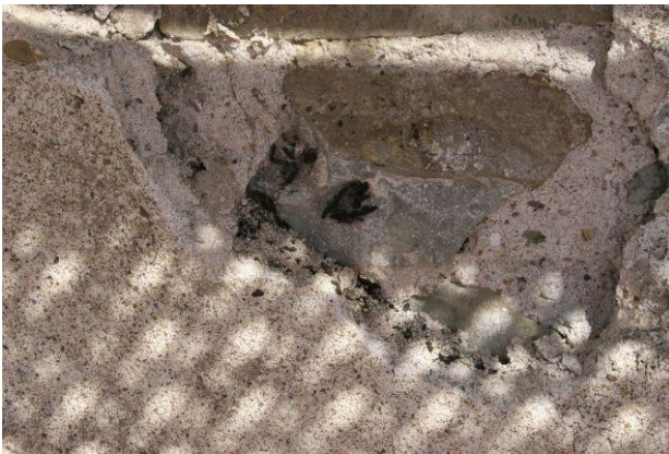
Abbildung 2: Bemerkenswert waren die Kotansammlungen hinter dem aufgesprengten Putz der Südseite.
