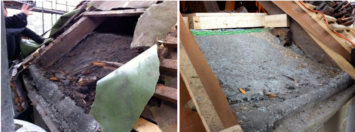
Abbildung 8: Dachkonstruktion ohne Möglichkeiten für Vogelbrutplätze vor Beginn (links) und kurz vor Abschluss der Sanierung. (Fotos: Sebastian Meyer)
