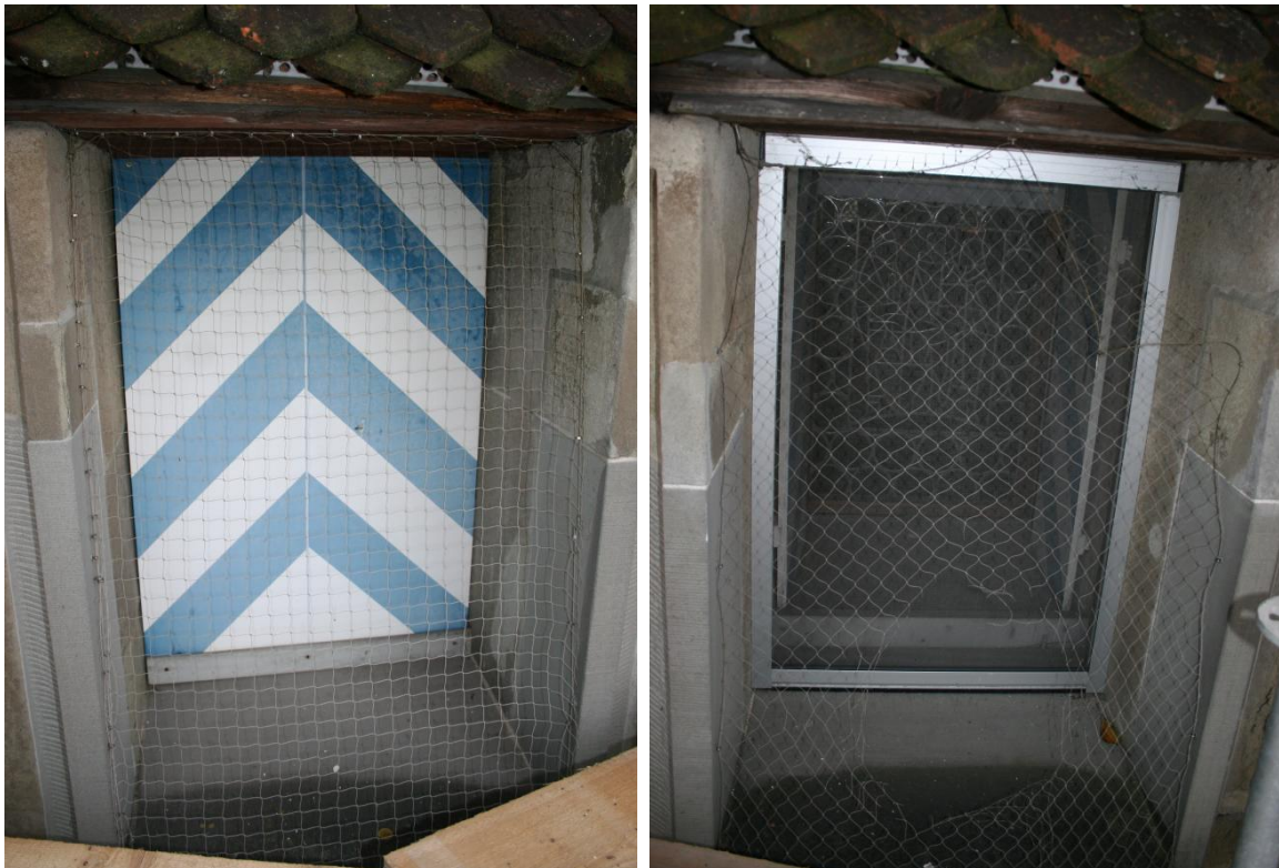
Abbildung 9: Fenster mit Taubenabwehrmassnahmen mit Netz. (Fotos: Sebastian Meyer)
