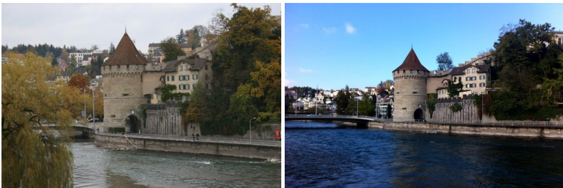
Abbildung 15: Nölliturm vor (links) und nach (rechts) der sanften Sanierung. (Fotos: Sebastian Meyer)
