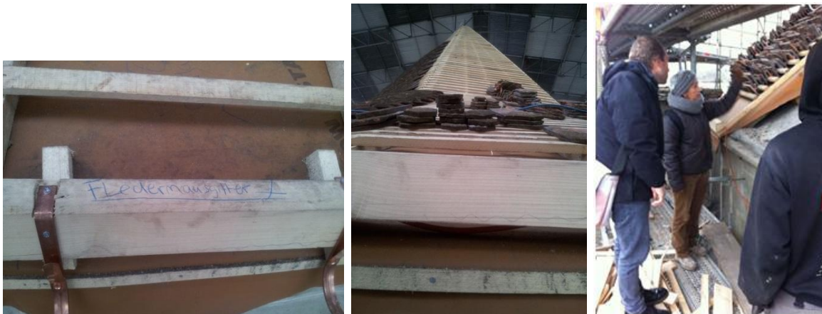
Abbildung 1: Der Bereich für die Fledermäuse wurde vorgängig mit den Handwerkern und dem Architekten festgelegt.
