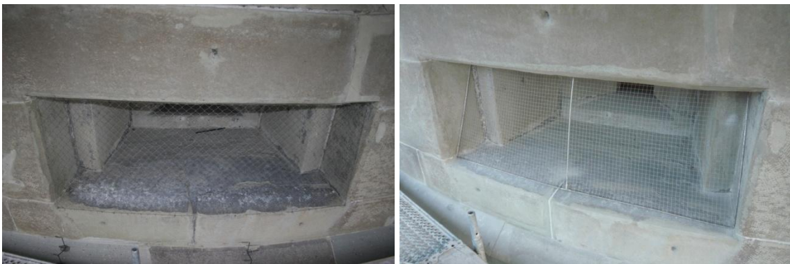
Abbildung 11: Nischen mit Taubenabwehrmassnahmen vor (links) und nach (rechts) der sanften Sanierung. (Fotos: Sebastian Meyer und Nils Wimmer)
