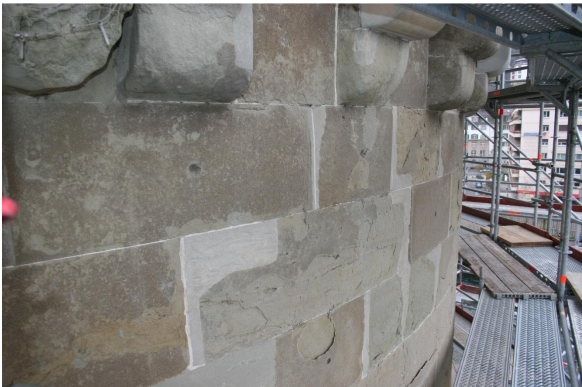
Abbildung 3: Ausschnitt aus der Fassade vor der Sanierung. (Fotos: Sebastian Meyer)
