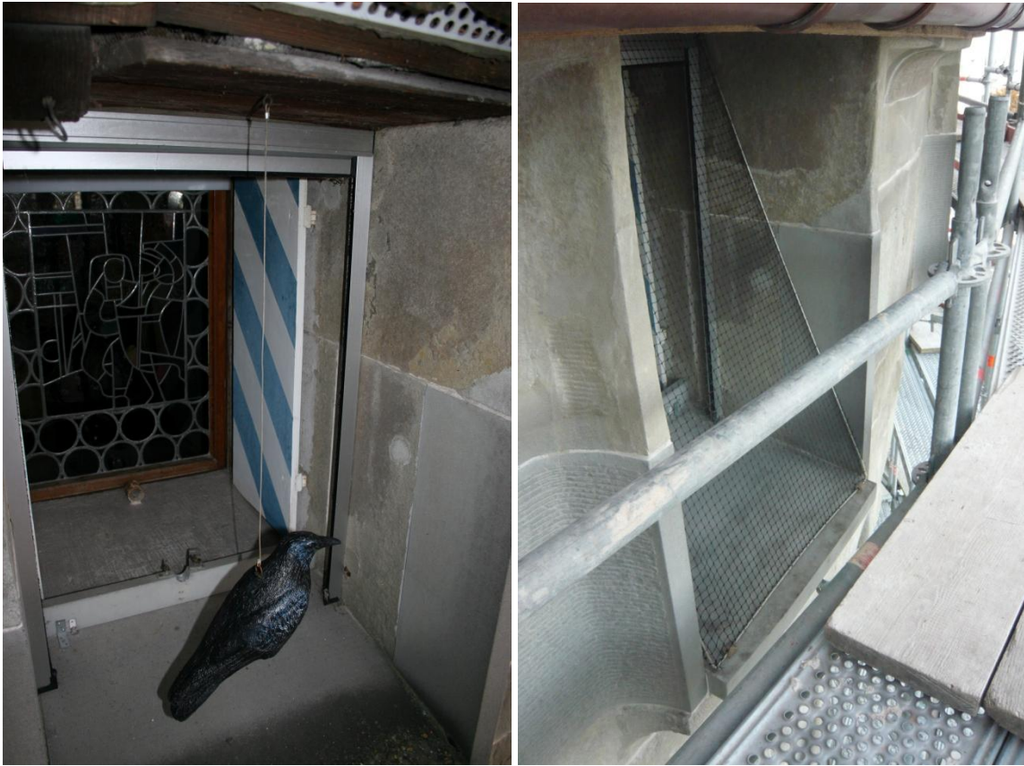
Abbildung 10: Krähenattrappe (links unten) vor und Netz nach (rechts unten) der sanften Sanierung. (Fotos: Sebastian Meyer)
