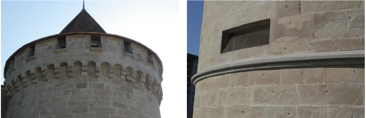
Abbildung 19: Wie bereits vor der Restaurierung sind die Sandsteinmauern des Nölliturms vollständig flechtenfrei. Auch die verschiedenen herausragenden Elemente, insbesondere die Sandsteinsime tragen nach den Restaurierungsarbeiten keine Flechten mehr.
