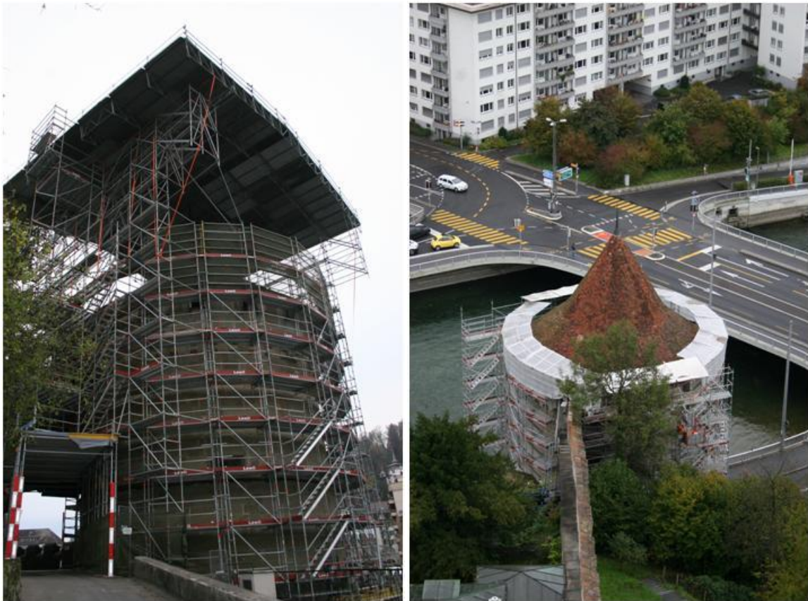
Abbildung 7: Nölliturm mit Gerüst, links mit Dachgerüst, rechts ohne. (Foto: Sebastian Meyer)
