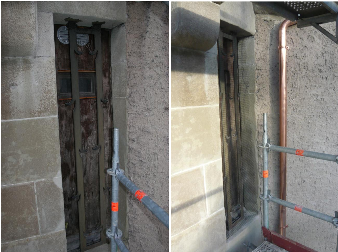
Abbildung 13: Türe über der Brüggligasse mit Taubenabwehrspikes vor (links) und Taubenabwehrnetz nach (rechts) der Sanierung. (Fotos: Sebastian Meyer)
