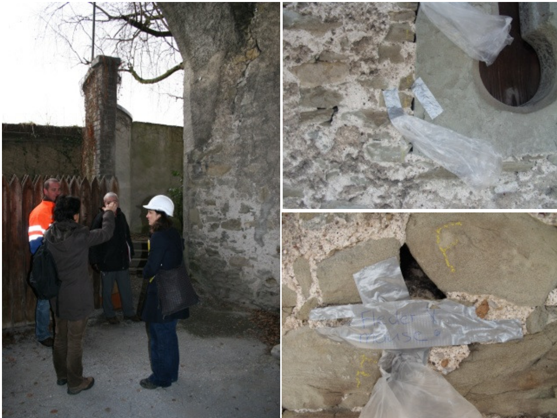
Abbildung 1: Vor den Injektionsarbeiten wird die Problematik der winterschlafenden Fledermäusen besprochen. Durch flatternde Plastiksäckchen sollen die Fledermäuse daran gehindert werden, nach ersten Ausflügen im Frühjahr wieder in ihre Spalten zurück zu kehren.
