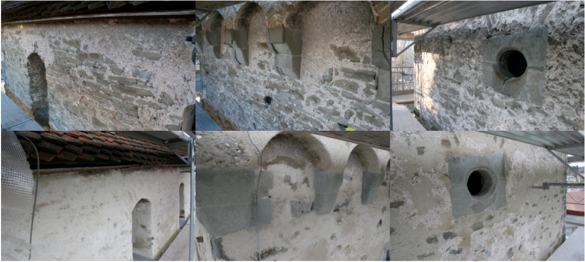
Abbildung 9: Ausschnitte aus der Fassade vor (oben) und nach (unten) der sanften Sanierung. (Fotos: Sebastian Meyer)
