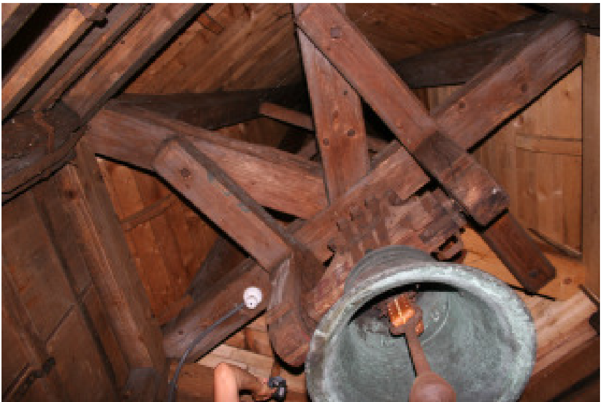
Abbildung 7: Der Dachstock ist grundsätzlich tauglich auch für Fledermausarten wie beispielsweise Langohren.
