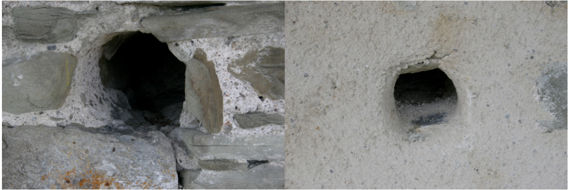
Abbildung 13: Alpengsegler-Brutplatz vor (links) und nach (rechts) der sanften Sanierung. (Fotos: Sebastian Meyer)
