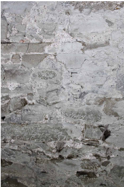
Abbildung 25: Die grossflächig deckenden Verunreinigungen mit Sedimentwasser im Bereich der Bohrungen sind für vorhandene Flechtenlager in diesem Ausmass zerstörerisch, links auf der Westseite des Wachturms, rechts auf der Ostseite mit Beeinträchtigung des benachbarten Mauerabschnitts.
