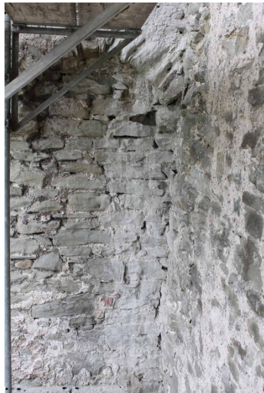
Abbildung 25: Die grossflächig deckenden Verunreinigungen mit Sedimentwasser im Bereich der Bohrungen sind für vorhandene Flechtenlager in diesem Ausmass zerstörerisch, links auf der Westseite des Wachturms, rechts auf der Ostseite mit Beeinträchtigung des benachbarten Mauerabschnitts.
