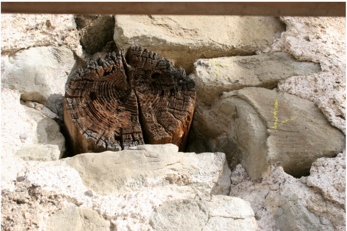
Abbildung 10: Ein Loch gefüllt mit einem alten Holz, rechts mit einem Mauersegler-Brutplatz. (Foto: Sebastian Meyer)
